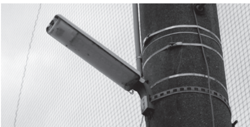
▲LED化された防犯灯
