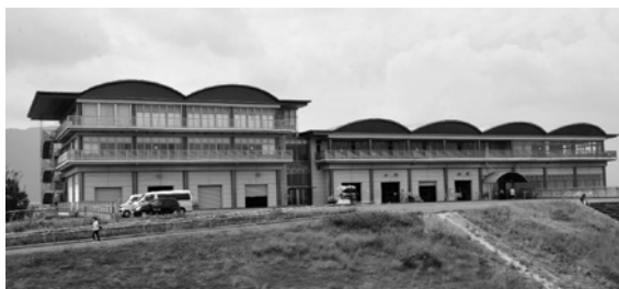
▲国営木曾三川公園 長良川サービスセンター
